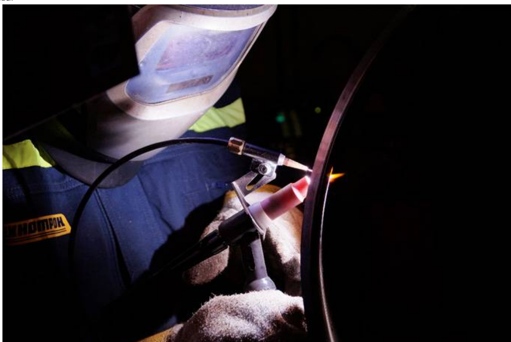
Сварка корневого прохода трубы 820x12
