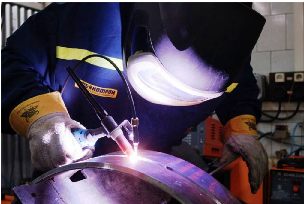
Сварка корневого прохода трубы 530x10
